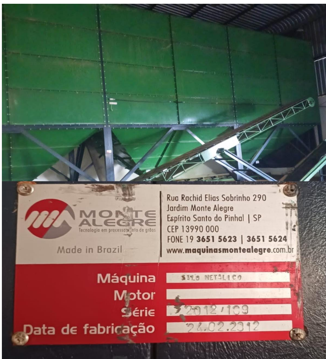
Figura 3: Silo metálico (60T) e placa de identificação
